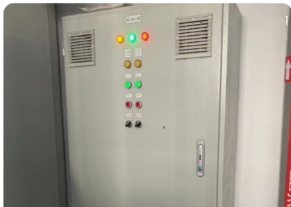
开展安全隐患大排查，定期限整改完成
